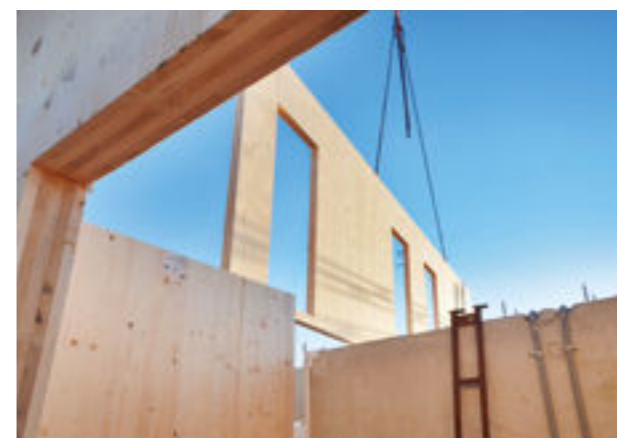
Elementene løftes rett fra bilhenger og inn på bygget.
