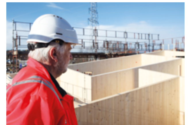
Så er det klart for å legge dekke-elementene..
